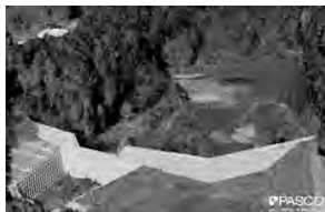
砂防堰堤の3次元モデルを構築し、 3次元管内図や施設管理に活用
