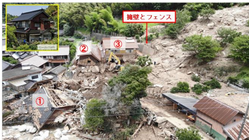
図 5.4.3 被災した宅地の様子
