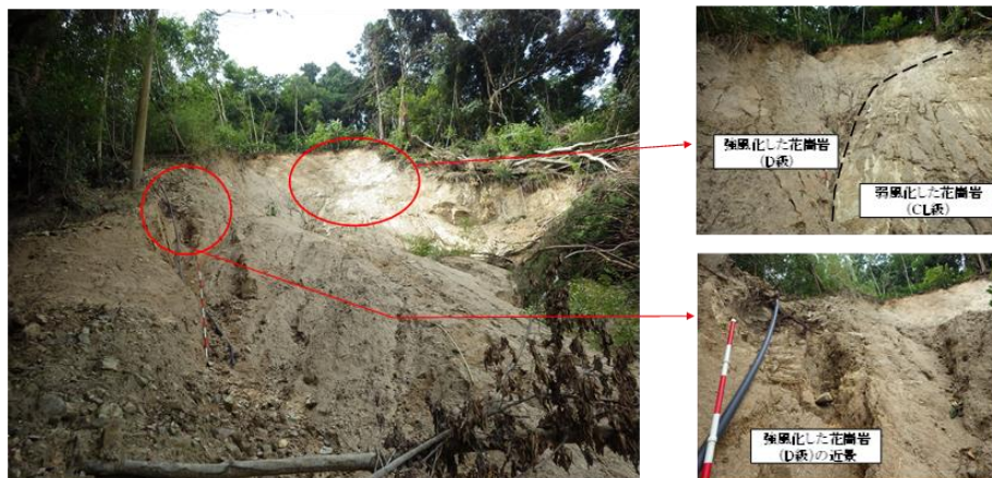
図 5.2.8 崩壊地（主要な土砂生産源）と基岩（花崗岩）の露出【ポイント番号②】
