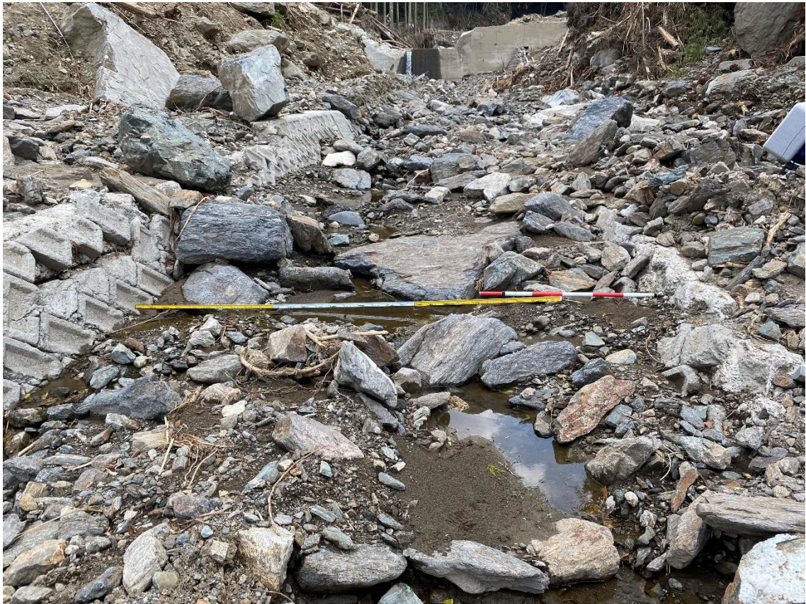
図 4.2.7 帯工と第5号床固工の区間における堆砂（令和5年7月29日撮影）
