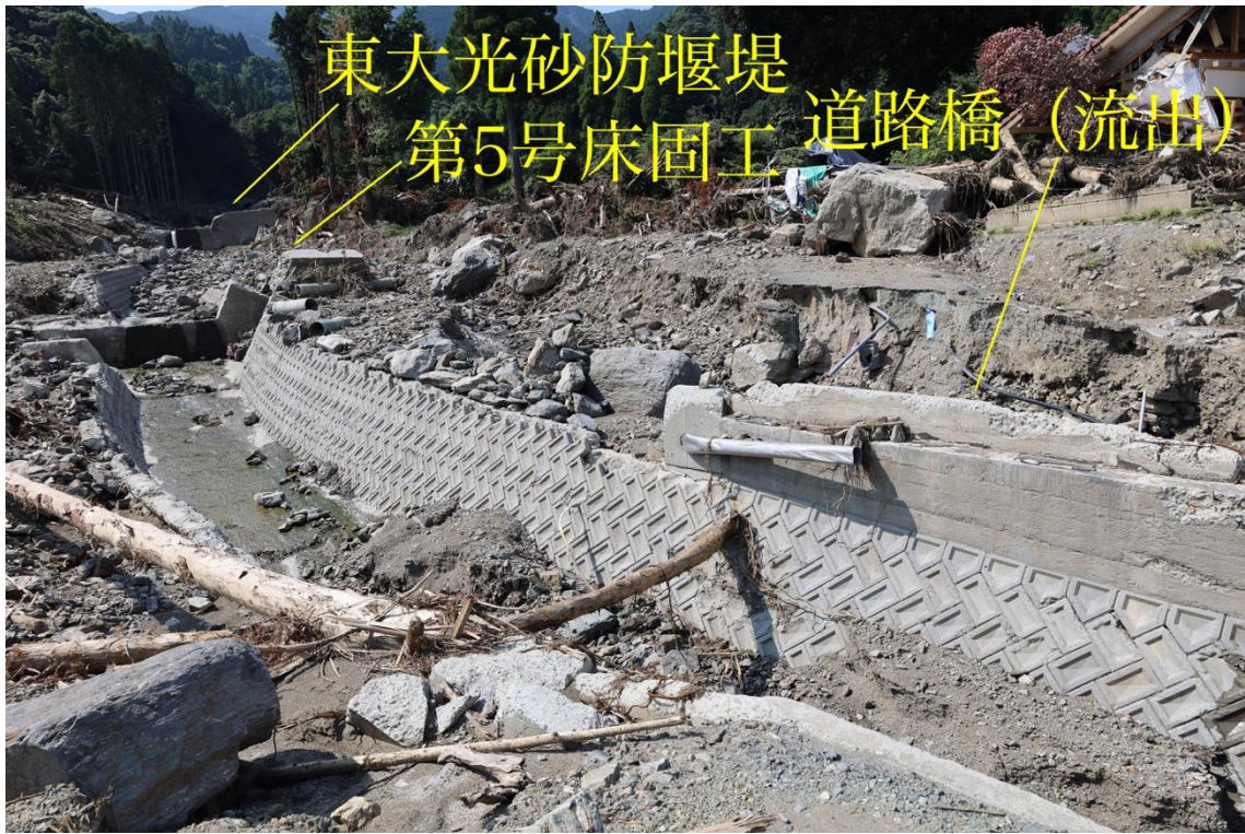
図 4.2.8 第5号床固工より下流の溪流保全工 (令和5年7月29日撮影)
