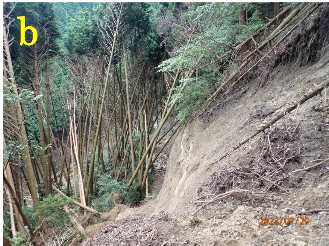
図 3. 2. 2. 2 千ノ尾川左支川の左岸斜面で発生した崩壊の上流側（2023 年 7 月 29 日撮影） a, b の撮影の位置および方向は図 3. 2. 2. 1 に示す
