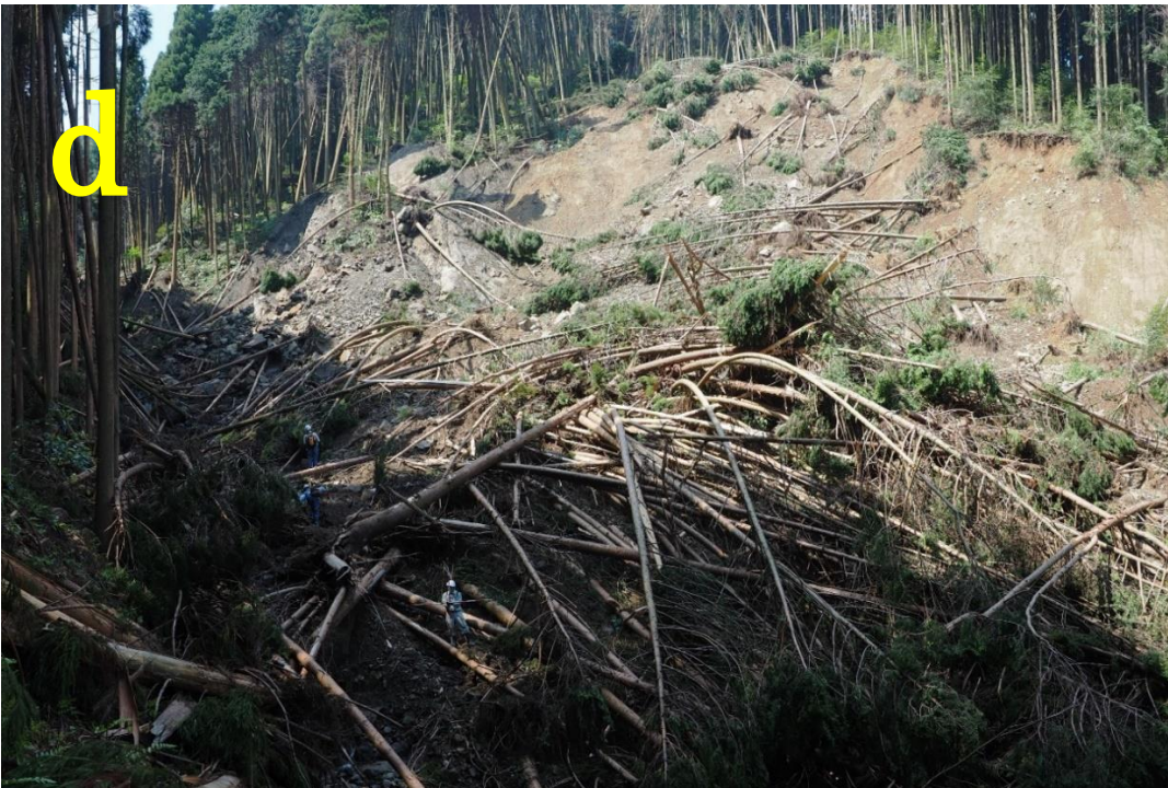
図 3.2.2.3 千ノ尾川左支川の左岸斜面で発生した崩壊の下流側（2023年7月29日撮影） c, dの撮影の位置および方向は図3.2.2.1に示す
