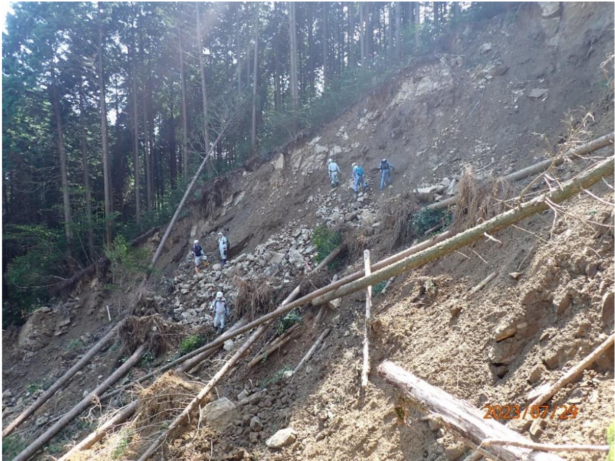
図 3.2.1.2 千ノ尾川の左支川源頭部の崩壊地（崩壊地の左岸から 2023 年 7 月 29 日撮影）
