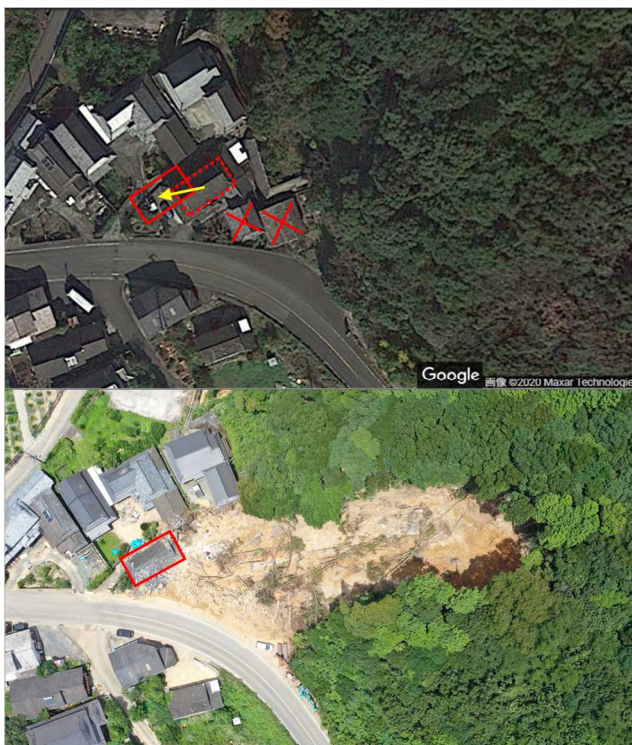
図 3.2.2 崩壊発生前の画像（上）と発生後の写真（下）の比較。上図の説明：点線の四角形は建物の 2 階の屋根を示し，それが実線の四角形的位置に移動した。2 つの×は消失した建物。下図の説明：赤色の四角形は移動後の 2 階の屋根。
