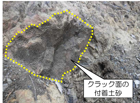
図 3.2.7 軟質砂岩中のクラック面土砂
