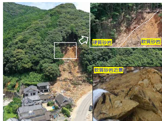
図 3.2.4 塩尾-4 崩壊地の地質状況
