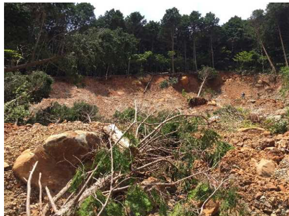
図 3.4.5 崩壊地の滑落崖とすべり面の全景
