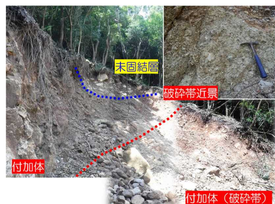
図 3.2.9 小崎川源頭部崩壊地内状況
