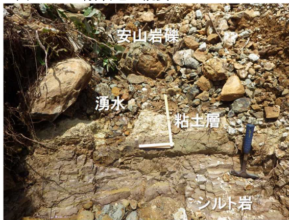
図 3.4.6 崩壊地内の湧水
