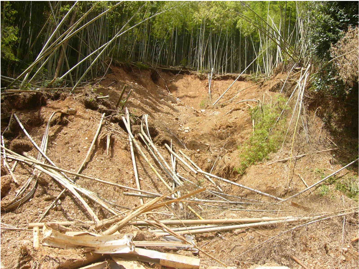
写真 3.3.1 崩壊斜面の全景
