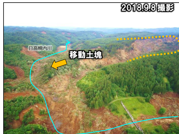
日高幌内川河道閉塞箇所
