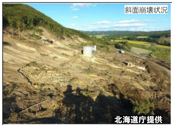
富里地区（大規模表層崩壊）
