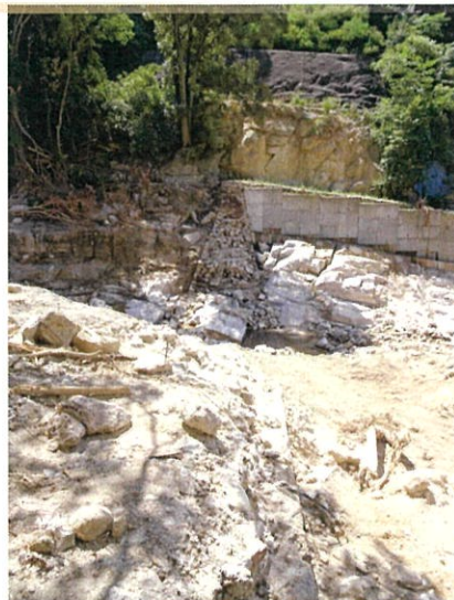
居住エリアの上流にあった石積みの砂防堰堤が破壊
