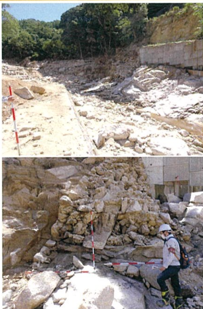
居住エリアの上流にあった石積みの砂防堰堤が破壊
