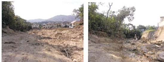
土石流の氾濫 転石を含むものの、土砂流的な流れで、住宅にも押し寄せるが、水路に沿って流下
