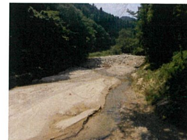
P1 不明堰堤堆砂域 第3班H30. 7. 26撮影
