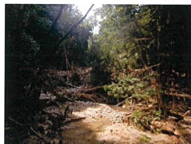
P3 不明堰堤堆砂域 第3班H30. 7. 26撮影
