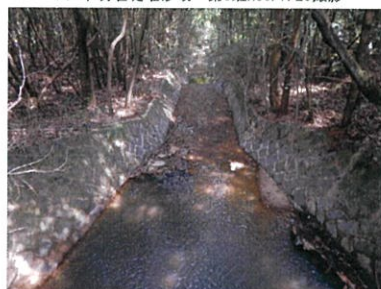
P4 堰堤下流の状況 第3班H30. 7. 26撮影
