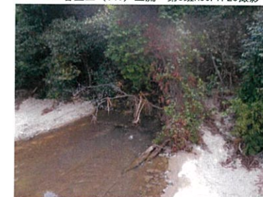
P6 光木川堰堤の堆砂状況 第3班H30. 7. 26撮影
