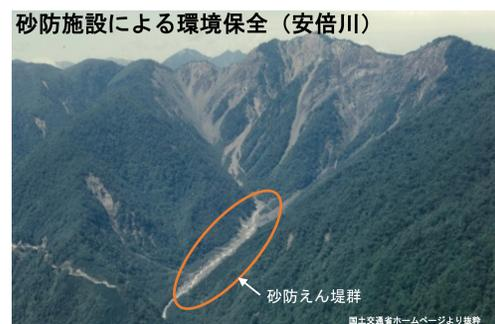
砂防えん堤などの整備により、上流の溪床が上昇して溪流沿いの斜面の足元が安定します。このため、斜面の土砂移動が少なくなり植物の種子が自然に入って発芽することが出来るようになり、自然環境が回復します。
