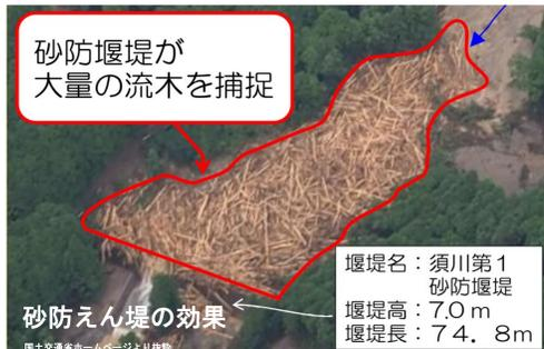
2017年の九州北部豪雨災害の際、朝倉市須川に整備された砂防えん堤が大量の流木の流出を防止し、土砂災害の発生を防ぎました。
