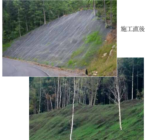
図-1 パワーネット工法による斜面安定
