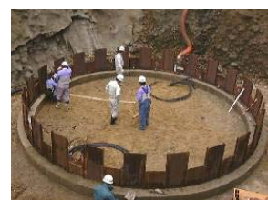
写真-2 鋼矢板設置
