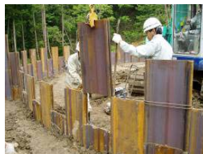
写真-3 鋼矢板挿入
