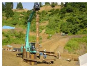
写真-1 鋼矢板基礎施工
