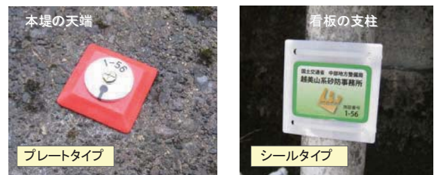
図2 ICタグの構成と設置写真
