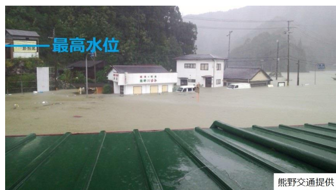
写真1 新宮市熊野川町志古の浸水状況 国道 168 号の最大浸水深：9m (2011年9月3日午前7時 39分撮影)
