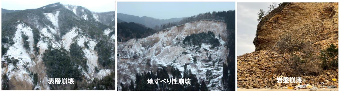
図-2 地震によって発生した崩壊地のタイプ分け
