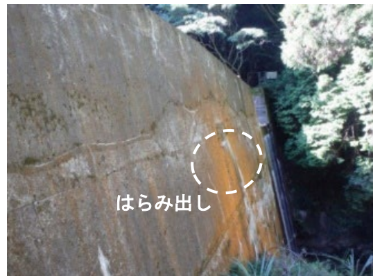
写真1 間谷堰堤の状況
