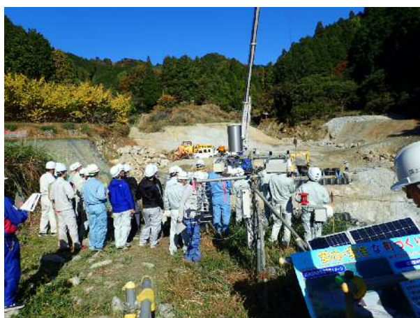
乙石川地点（堰堤工事・国交省）
