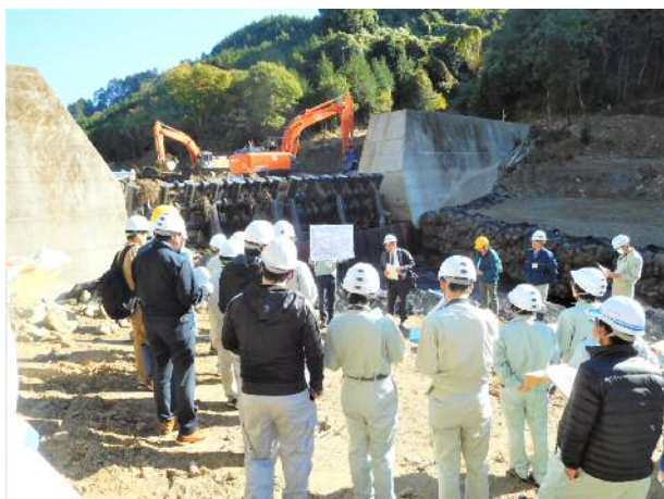
奈良ヶ谷川地点（堰堤改良・福岡県）
