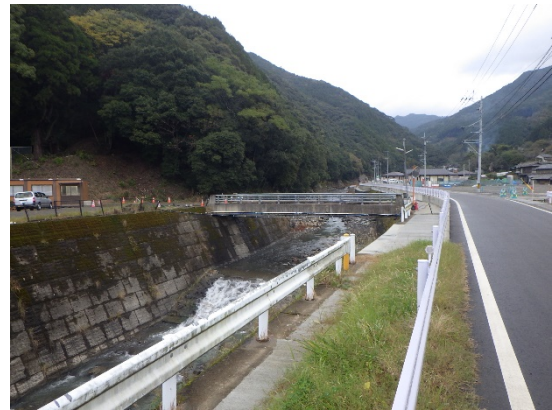
(氾濫被害箇所の様子)
