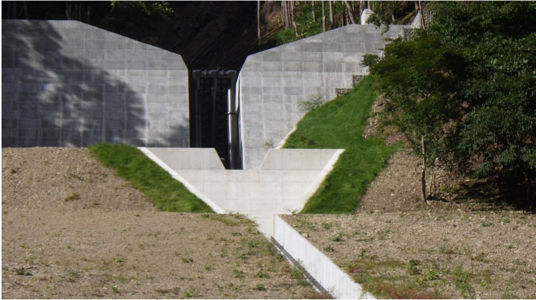
写真-3 下坪上沢砂防堰堤（高さ 10.5m、長さ 50m）
