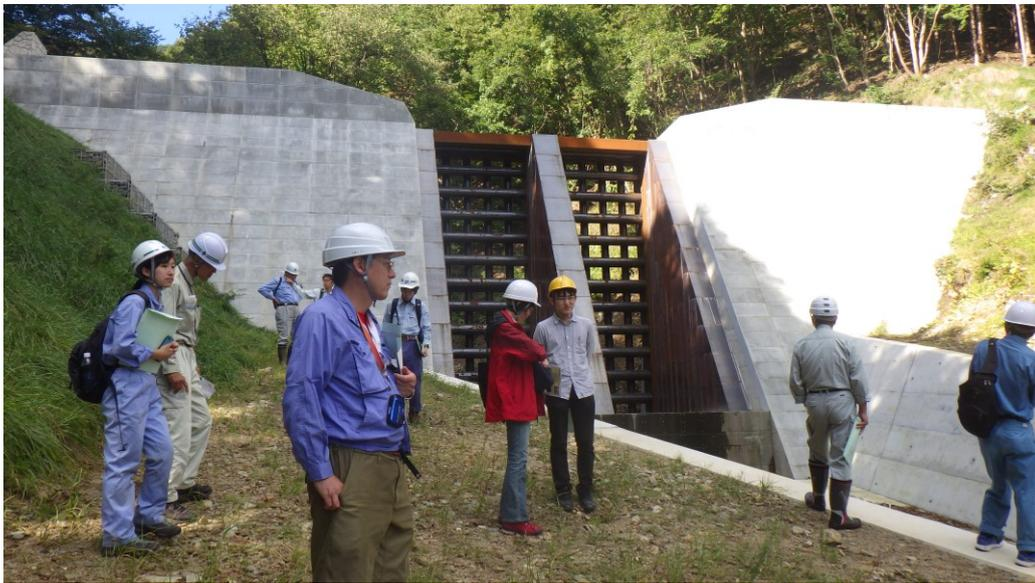
写真-2 下坪沢砂防堰堤（高さ 14m、長さ 48.5m）
