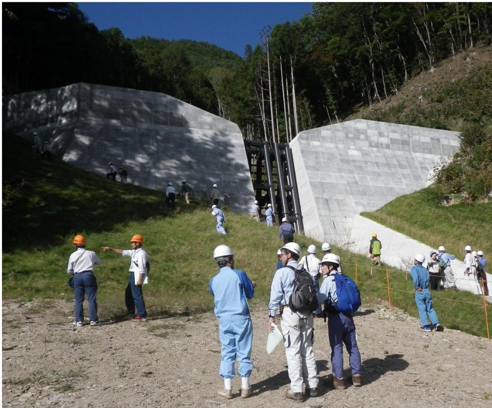
写真-4 滝向沢砂防堰堤（高さ 13.5m、長さ 56m）
