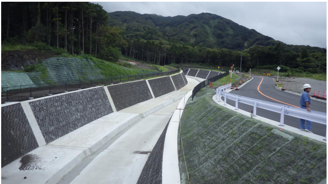
写真-6 完成した下流導流堤（大金沢左支川、神達地区付近）
