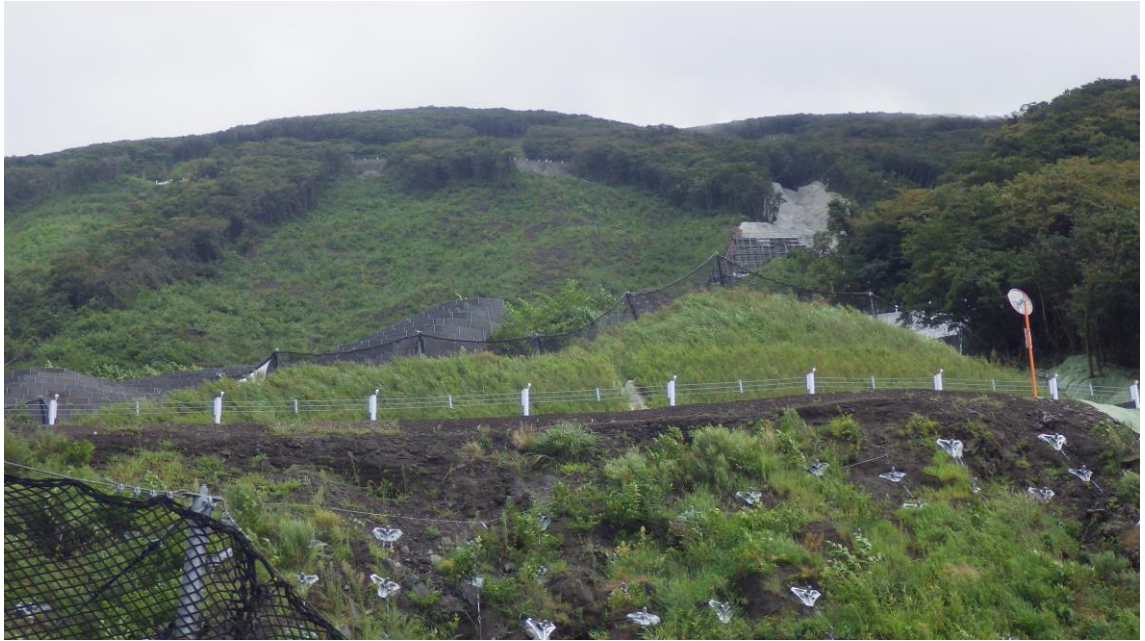
写真-5 大金沢上流域の復旧工事ののり面工、斜面安定工、床固、水路工
