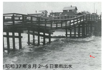
図 25 落橋寸前の富茂登橋
