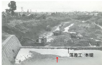
図 22 流路工の河道掘削状況
