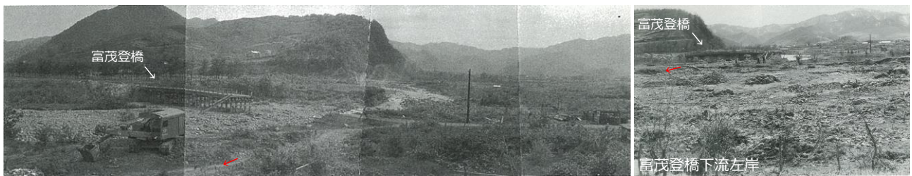
図 19 流路工施工前の河道状況 (S34.4.23～24 の融雪出水で落橋した富茂登橋)
