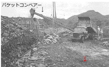
図 24 落差工のコンクリート打設状況
