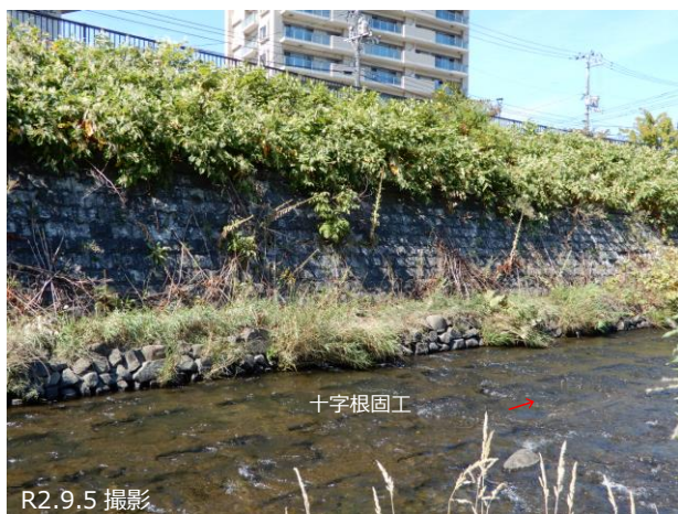
図30 道内最古の積ブロック護岸（施工後61年）
