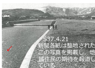
図 28 発寒橋上流の流路工 (左岸側)
