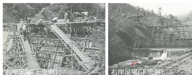
図 15 平和堰堤 施工中 (S30)
