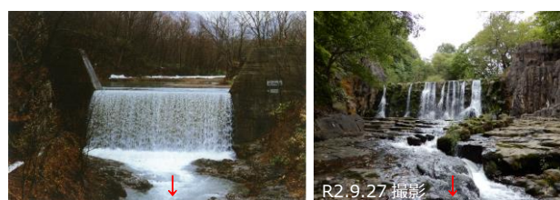
図 17 福井堰堤 完成後 [右図] H8 修景・魚道設置後
