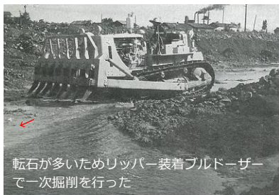
図 21 流路工の河道掘削状況
