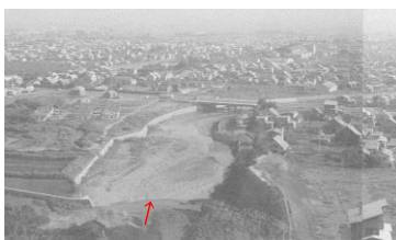
図 26 流路工の上流端に設けられた沈砂地
