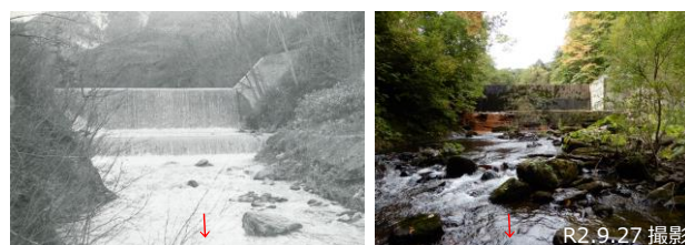
図 16 平和堰堤 完成後 [右図] H12 魚道設置後
