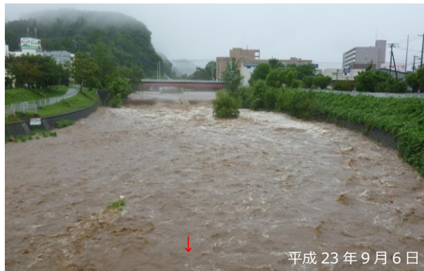
図37 「富茂登橋」上流の出水状況
