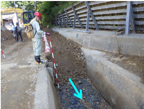
写真① 治山ダム下流の流路状況
