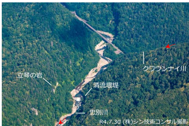
■ 忠別川砂防堰堤（清流堰堤）
