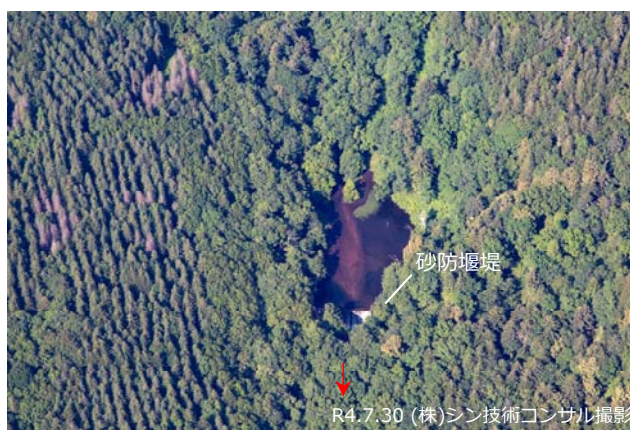
■ ノカナン沢川砂防堰堤
