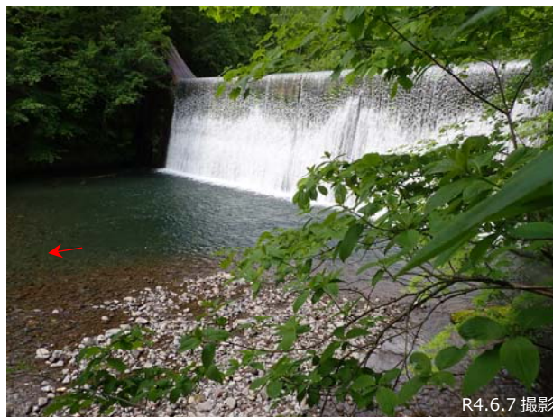
図-13 粗石コンクリートで築造されたピウケナイ川砂防堰堤
