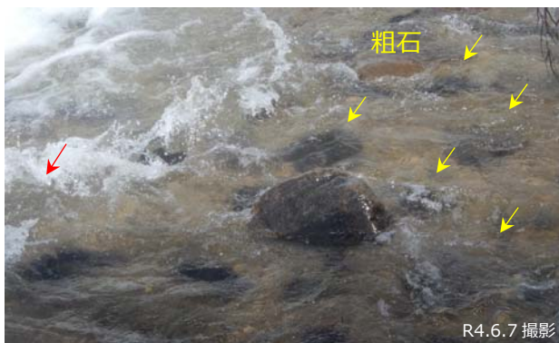
図-12 忠別川砂防堰堤 水叩部 粗石コンクリート
