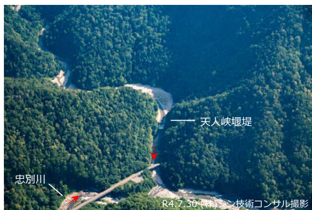
■ クワウンナイ川砂防堰堤（天人峡堰堤）
