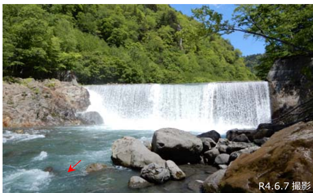
図-10 粗石コンクリートで築造された忠別川砂防堰堤
