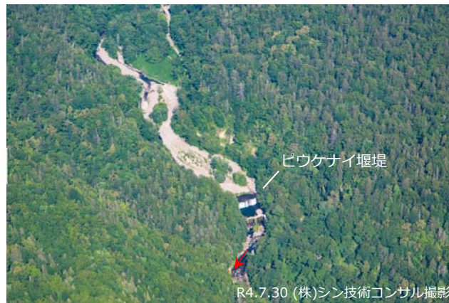
■ ピウケナイ川砂防堰堤（ピウケナイ堰堤）
