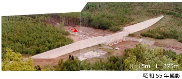
図一30 石狩川水系富良野川 3 号砂防堰堤 現場練りコンクリートで築造した 道内で最後の砂防堰堤（S48～S55、S59） （コンクリート立積 26,545 m 3 の内、 現場練り 21,251 m 3 、S48～S53 まで）
