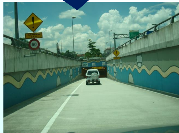
SMARTプロジェクトの 道路トンネル入り口
