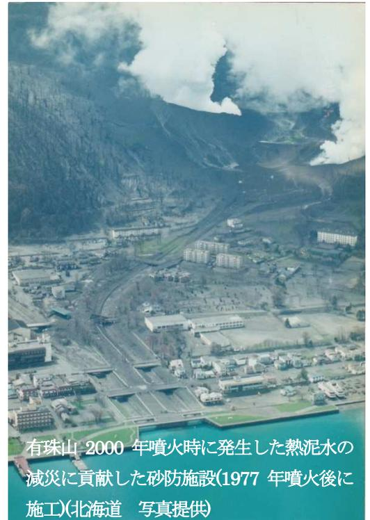
有珠山 2000 年噴火時に発生した熱泥水の減災に貢献した砂防施設(1977 年噴火後に施工)(北海道 写真提供)
