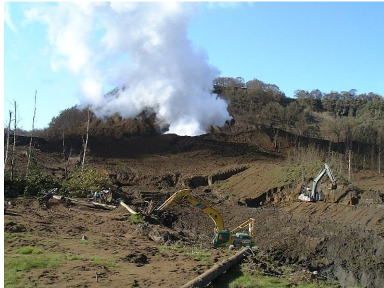
流路工の掘削および土砂搬出
