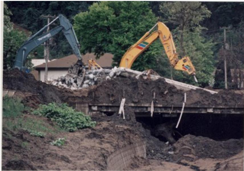
流出したこんぴら橋の取り壊し・撤去
