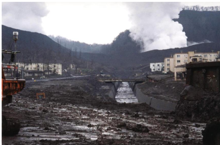
流路工の掘削完了
