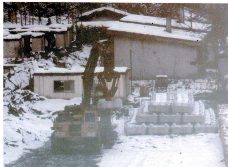
緊急導流堤(ブロック)の据え付け
