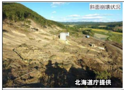
図-14 富里地区斜面崩壊全景 (①)
