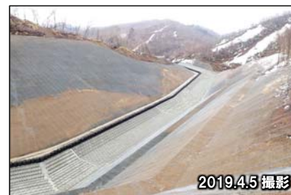
図-19 排水路整備状況
