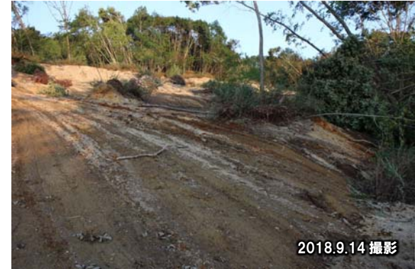
図-4 緩勾配斜面表層崩壊箇所
