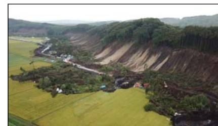
図-22 吉野地区崩壊箇所全景 (①)
