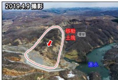
図-20 日高橋内川河道閉塞箇所全景
