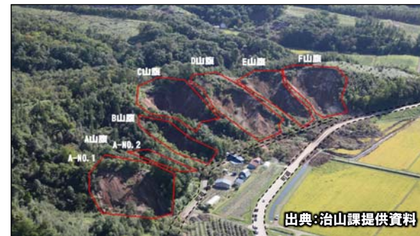
図-9 連続的に発生している斜面崩壊群
