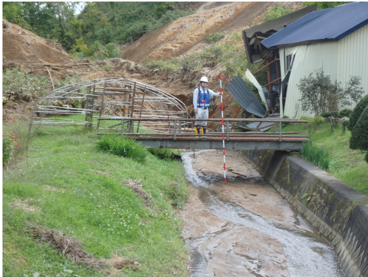
▲東和川沿いの人家近くの河床上昇 2018.9.13撮影
