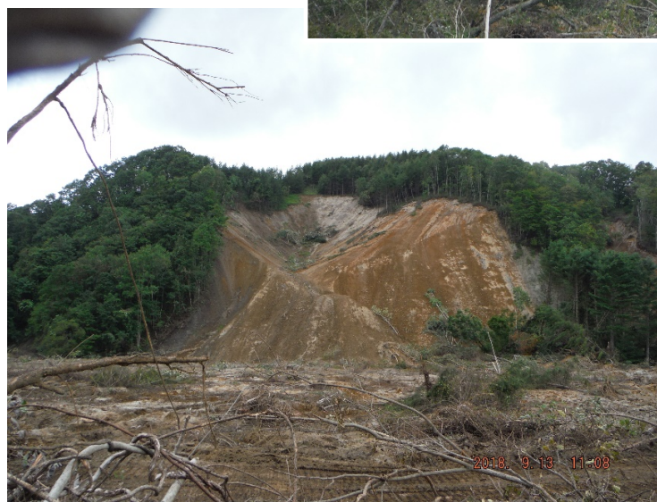
I -c 斜面崩壊 複合タイプ
