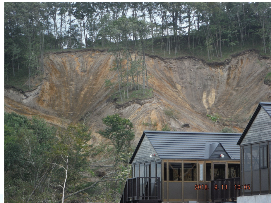
I -b 斜面崩壊 谷状タイプ
