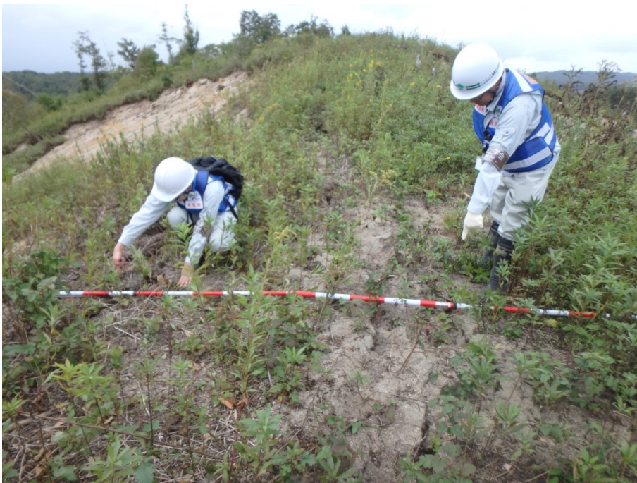
▲崩壊地の先端部のひび割れ
