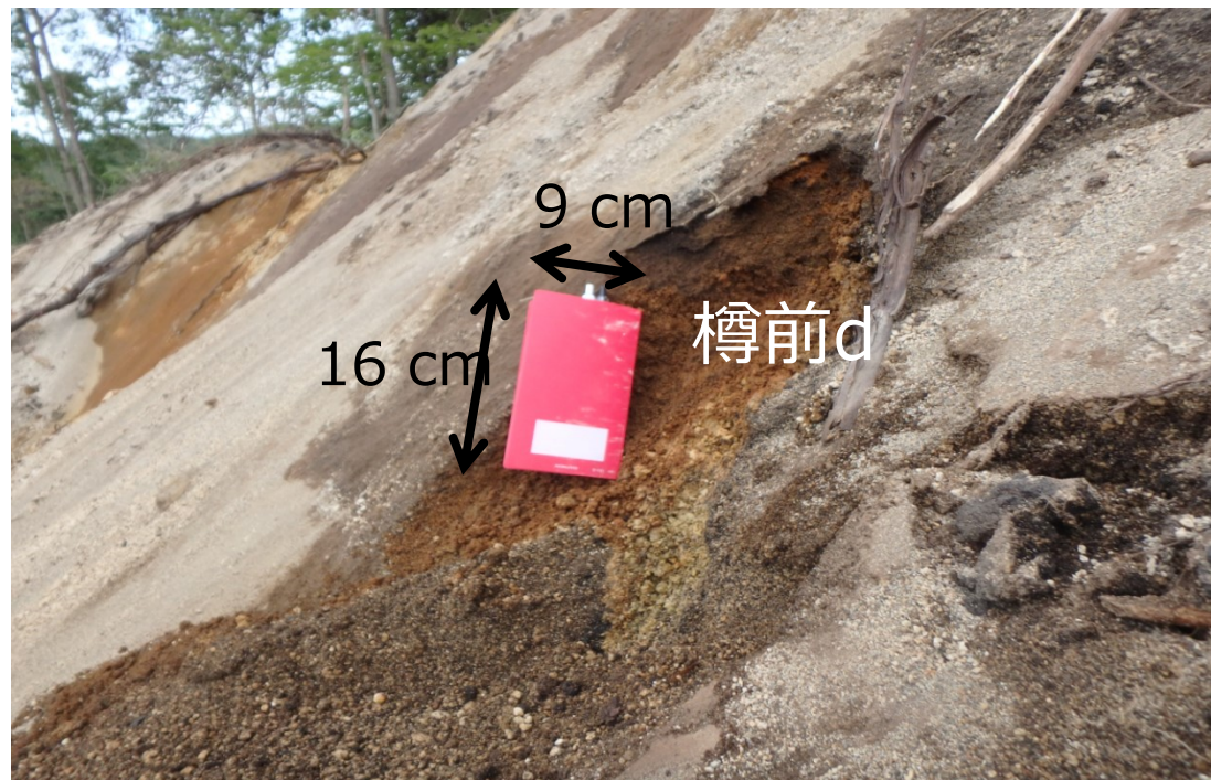
▲樽前dが露出している箇所
