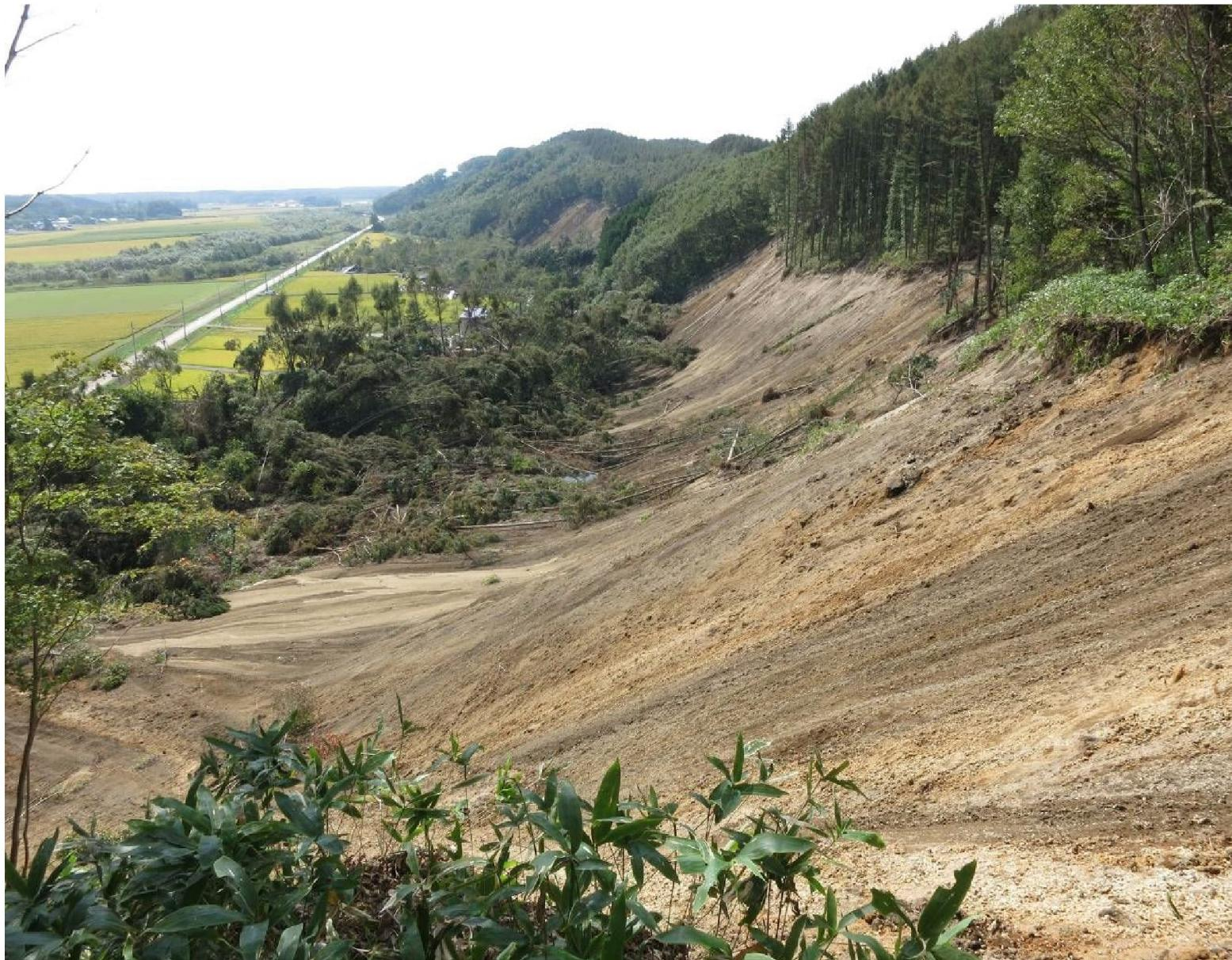
図-5 平滑型の崩壊斜面の傾斜は一樣
