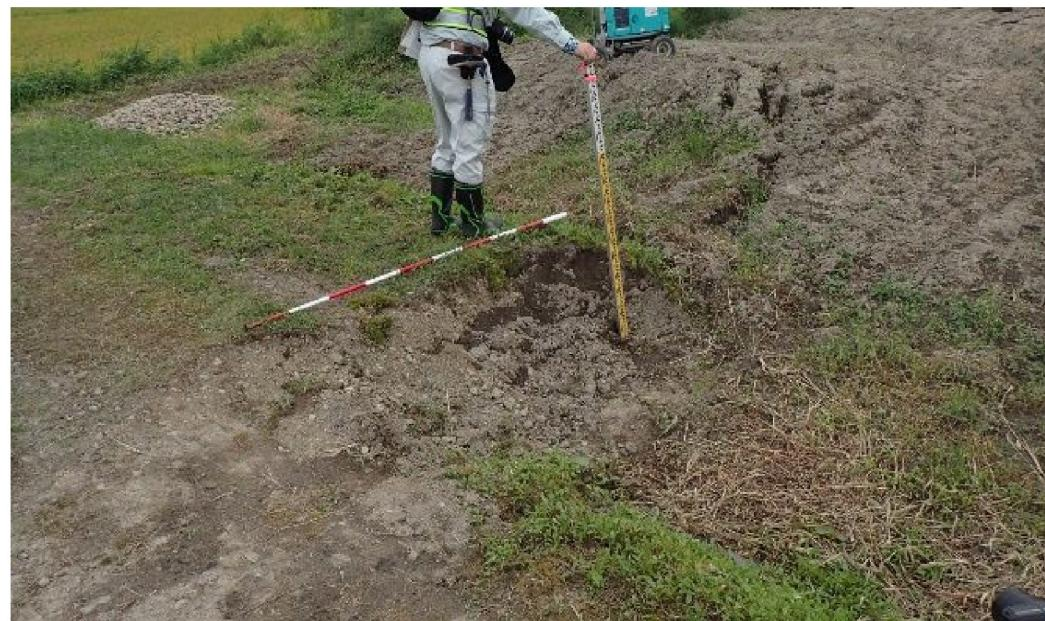
図-13 農道の横ずれ状況
