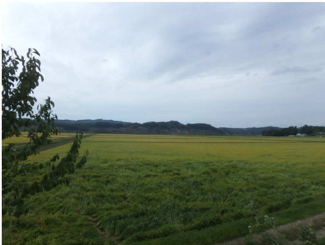
写真－9 吉野地区の崩壊（遠景，東和地区から北東方向を見る）
