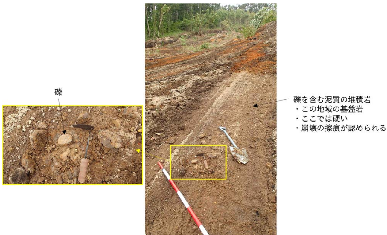
写真－3 桜丘地区の表層崩壊 崩壊地中部～脚部の底部
