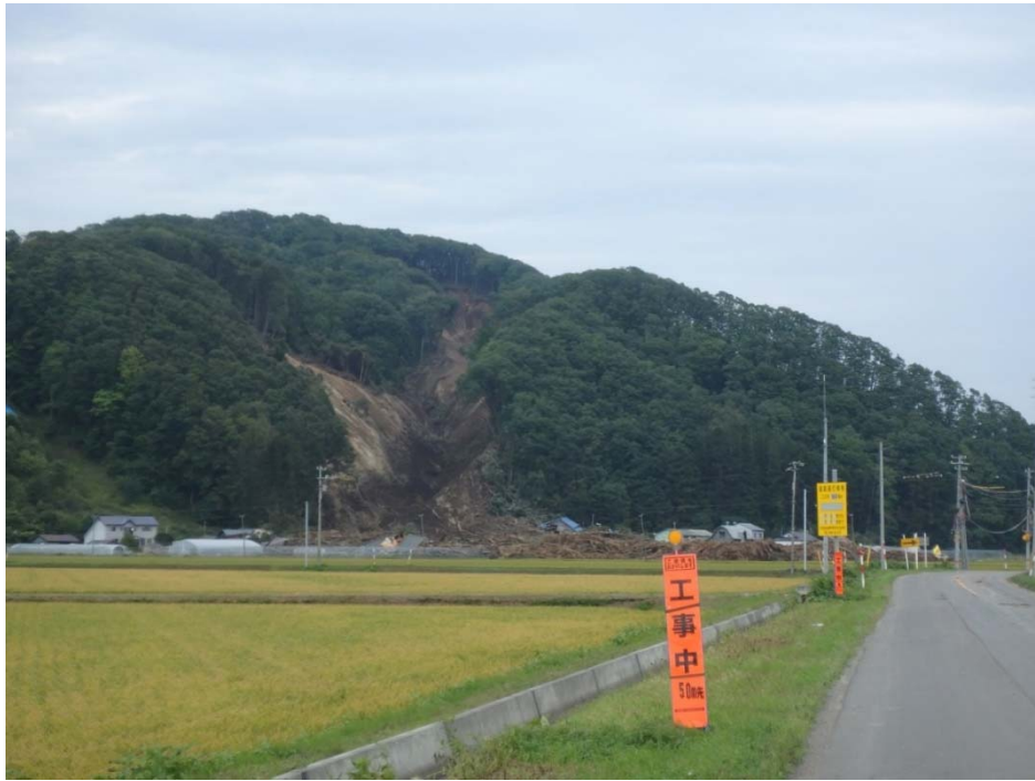
写真－11 富里地区における谷地形での土砂移動現象
