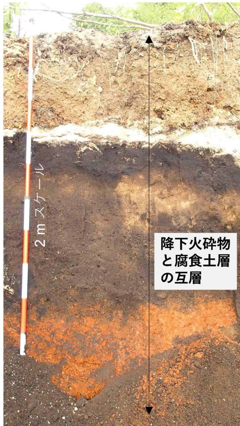
写真－2 桜丘地区の表層崩壊 崩壊地左岸中部露頭
