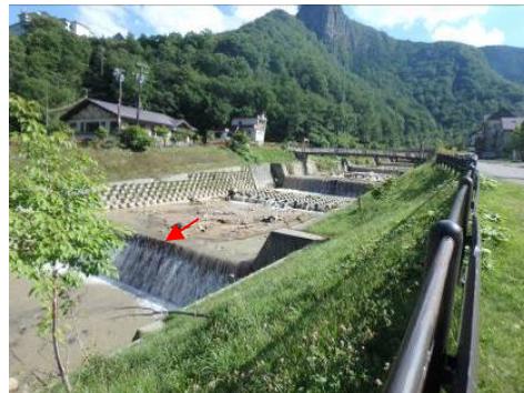
写真9 砂防堰堤下流の溪流保全工
