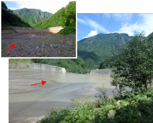
写真4 砂防堰堤による土砂の捕捉 (左上の捕捉前の写真は7/8撮影)
