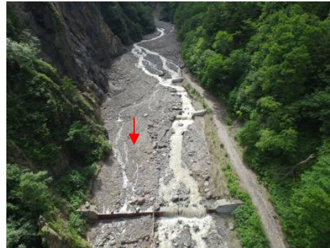
写真7 治山堰堤による土砂の捕捉 (UAVからの撮影) (提供：国土交通省北海道開発局)
