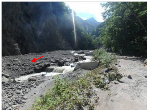
写真6 治山堰堤による土砂の捕捉
