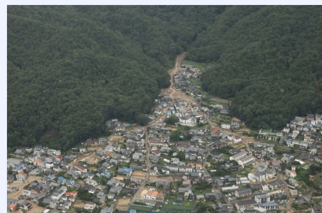
被災箇所 (航測写真)
