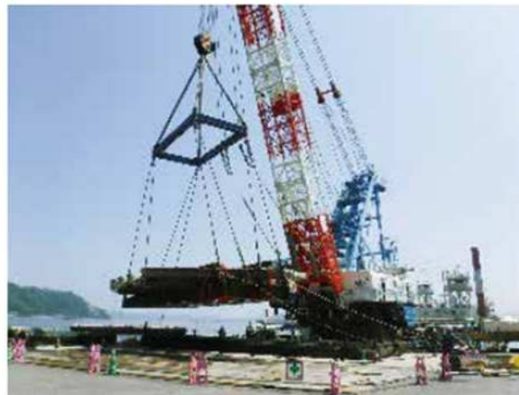
港湾工事(木江港)
