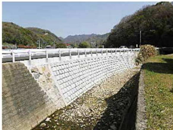
河川災害復旧工事(木谷郷川)
