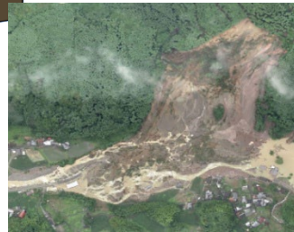
大分県日田市で発生した地すべり (H29.7 人家損壊7戸)
