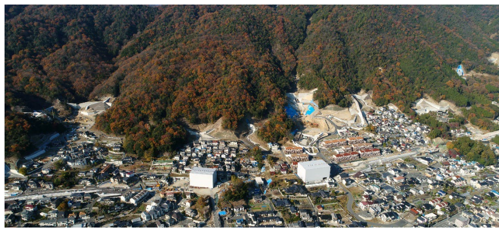
H26.8豪雨における砂防堰堤整備(広島県広島市安佐南区緑井～八木)
