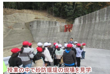
授業の中で砂防堰堤の現場を見学
