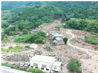
福岡県久留米市で発生した土石流 (R5.7)
