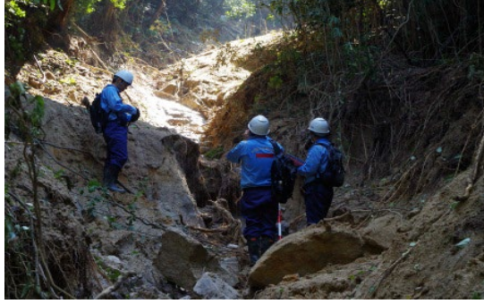
溪流の緊急点検状況
