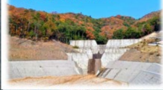
完成した小原山砂防堰堤
