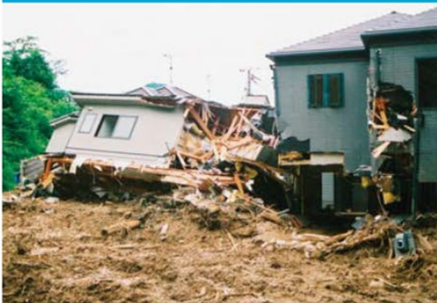
平成11年6月29日土砂災害
