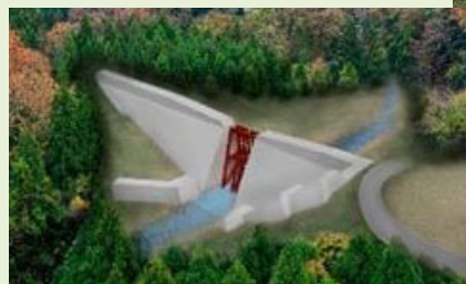
砂防堰堤の3D設計 (斜め写真と3次元モデルを合成)
