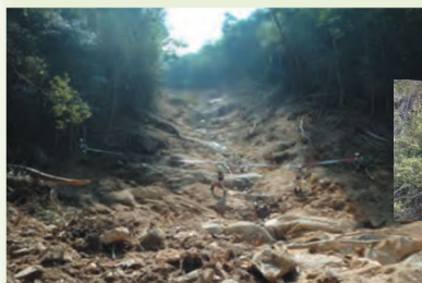
ドローン等による 溪流点検
