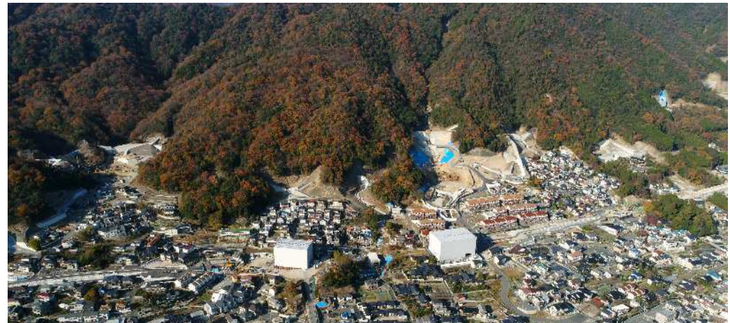
H26.8豪雨における砂防堰堤整備 (広島県広島市安佐南区緑井～八木)
