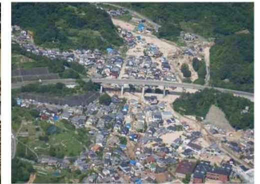
H30年7月豪雨 広島県呉市
