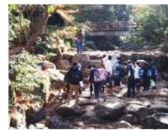
観光スポット「史跡名勝厳島」(紅葉谷川庭園砂防施設)
