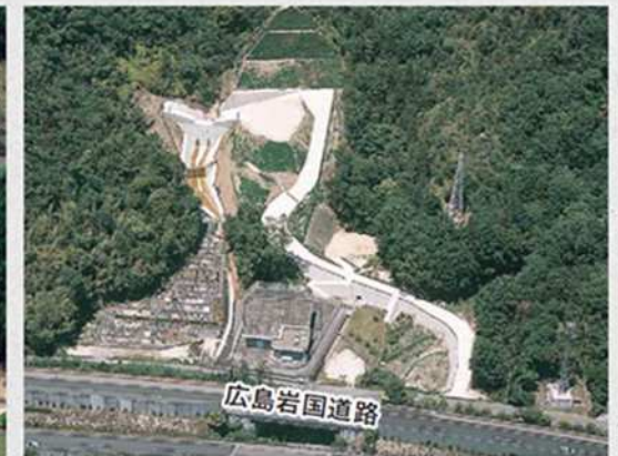
玖波砂防堰堤 (大竹市玖波)
