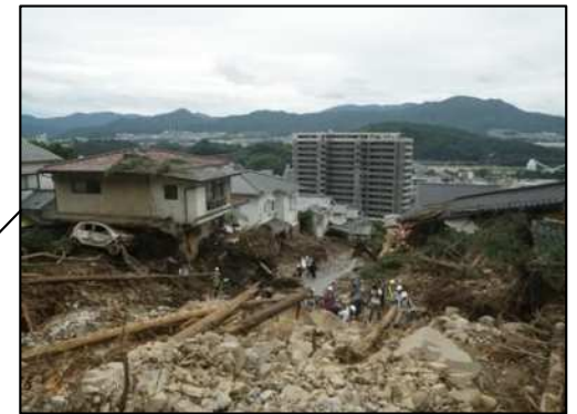
土石流と多くの流木により家屋が倒壊 (安佐南区八木3丁目阿武の里団地)
