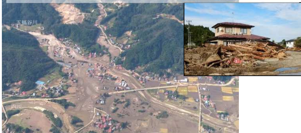
令和元年東日本台風 主要地方道の被災状況 (宮城県伊具郡丸森町)
