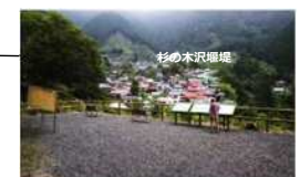
展望台からの砂防堰堤を望む(有東木夢プロジェクト)
