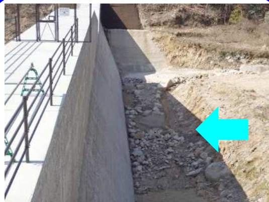
土石流発生前 (H29.3.9撮影)
