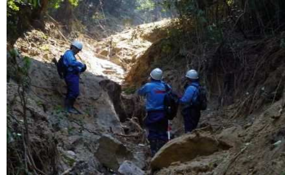
溪流の緊急点検状況
