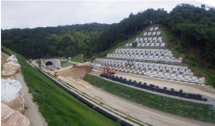
20180605 ソイルセメント盛土1段目着手
