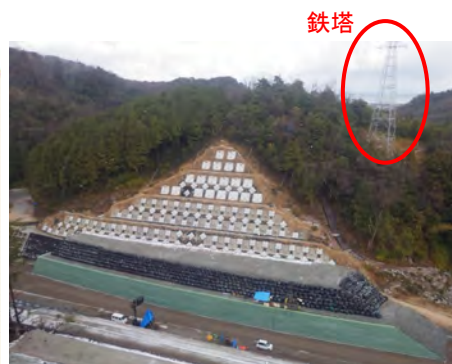
押え盛土全景
