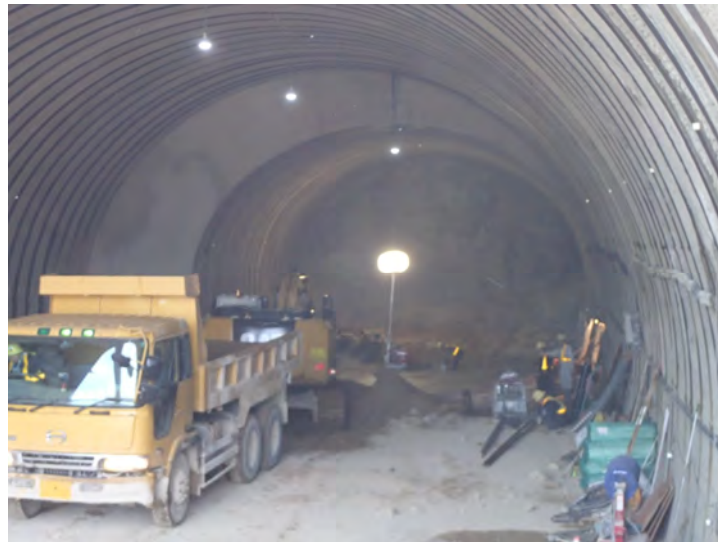
トンネル掘削
