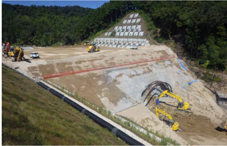
20180903 ソイルセメント盛土2段目施工中
