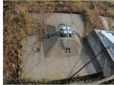
既設アンカー飛び出し防止対策
