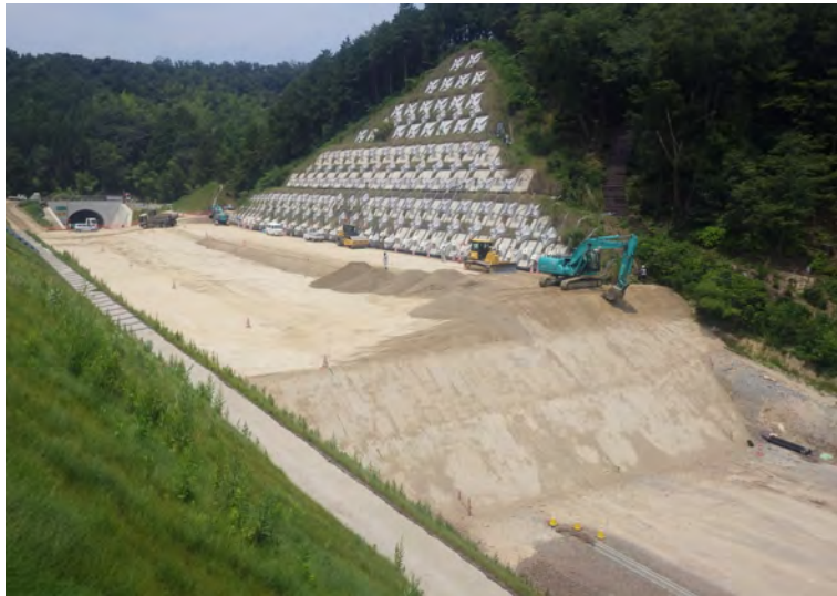
20180717 ソイルセメント盛土1段目ほぼ完成
