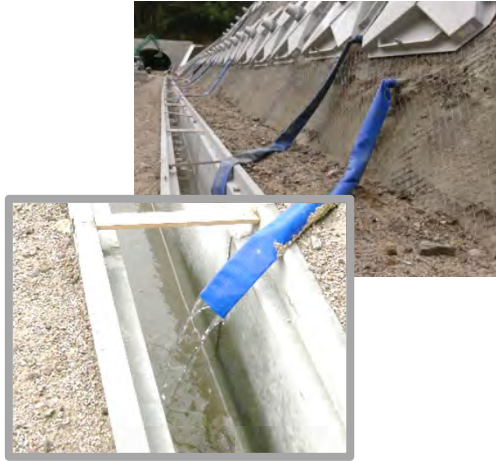
水抜ボーリング (アンカーと平行に掘削)
