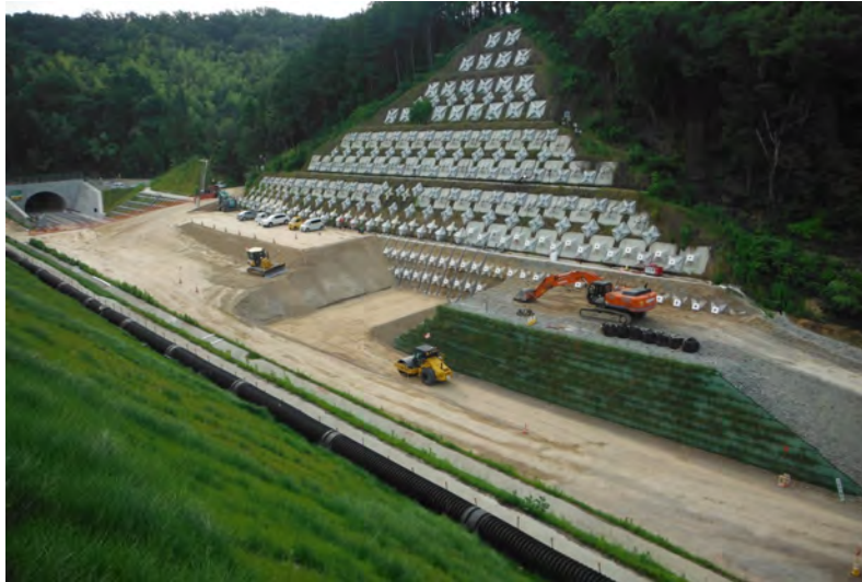
20180622 ソイルセメント盛土1段目施工中
