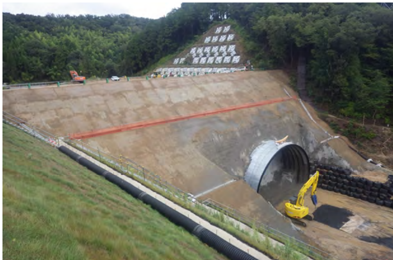
20180910 ソイルセメント盛土2段目施工中
