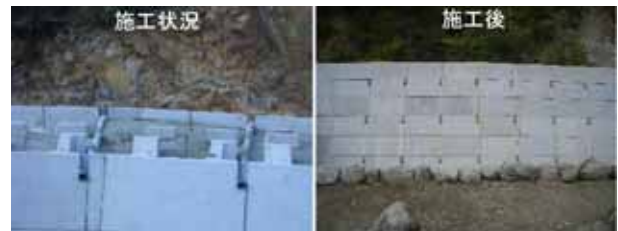
写真-2 カーブ区間の施工状況
