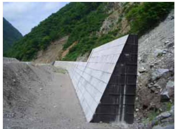
写真-3 施工後（全景）
