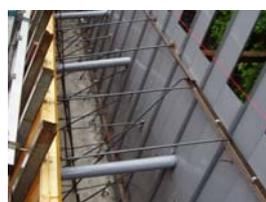
写真-3 擁壁裏型枠
