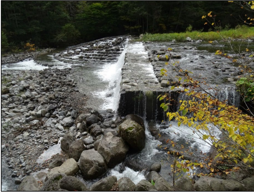
現場見学会① 蔦川砂防環境整備事業
