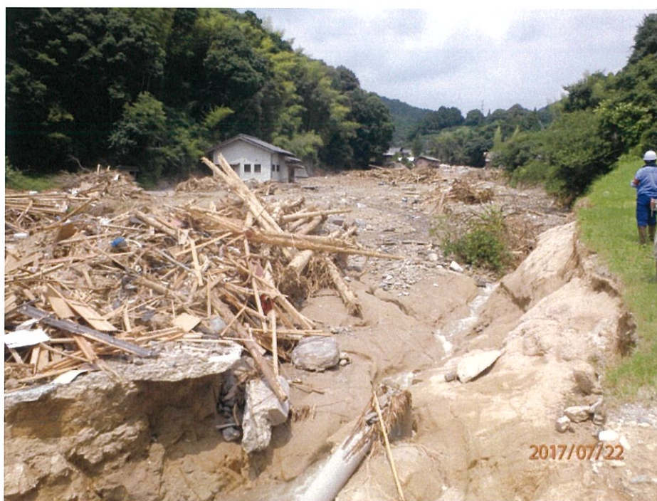
写真－3.5 北川・道目木地区における氾濫による被害状況
