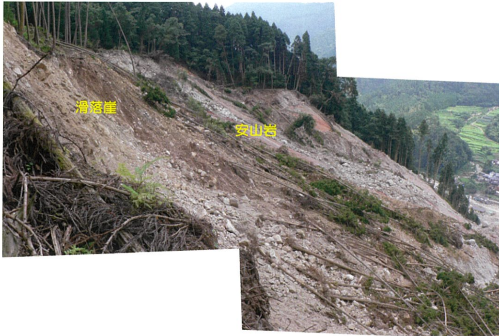
写真－4.4 小野地区の崩壊地の状況
