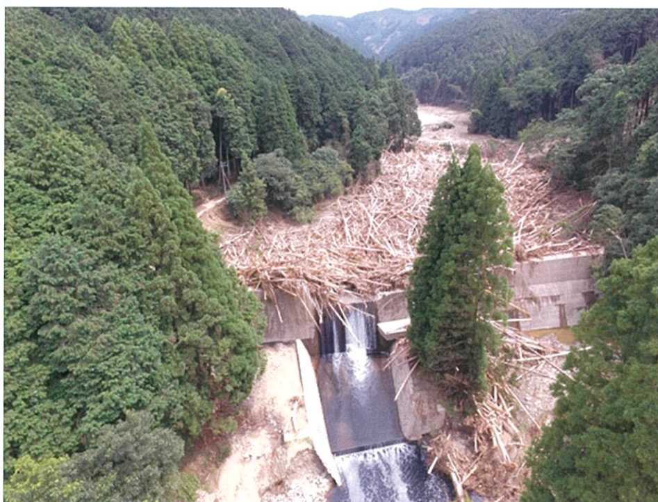
写真－3.3 妙見川・須川第一砂防堰堤における流木堆積状況
