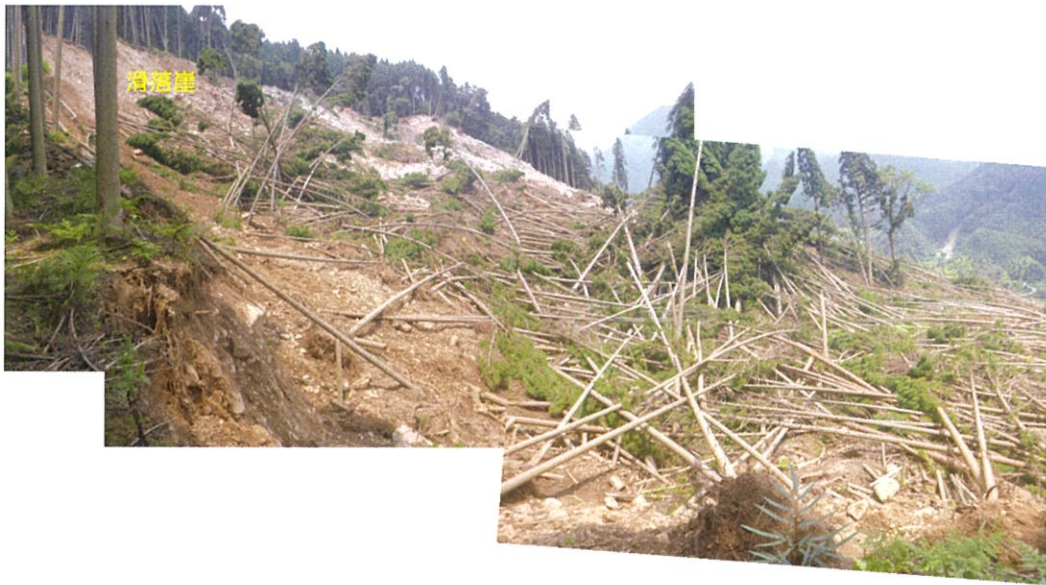
写真－4.5 崩壊地内に残存した崩壊土砂とスギ
