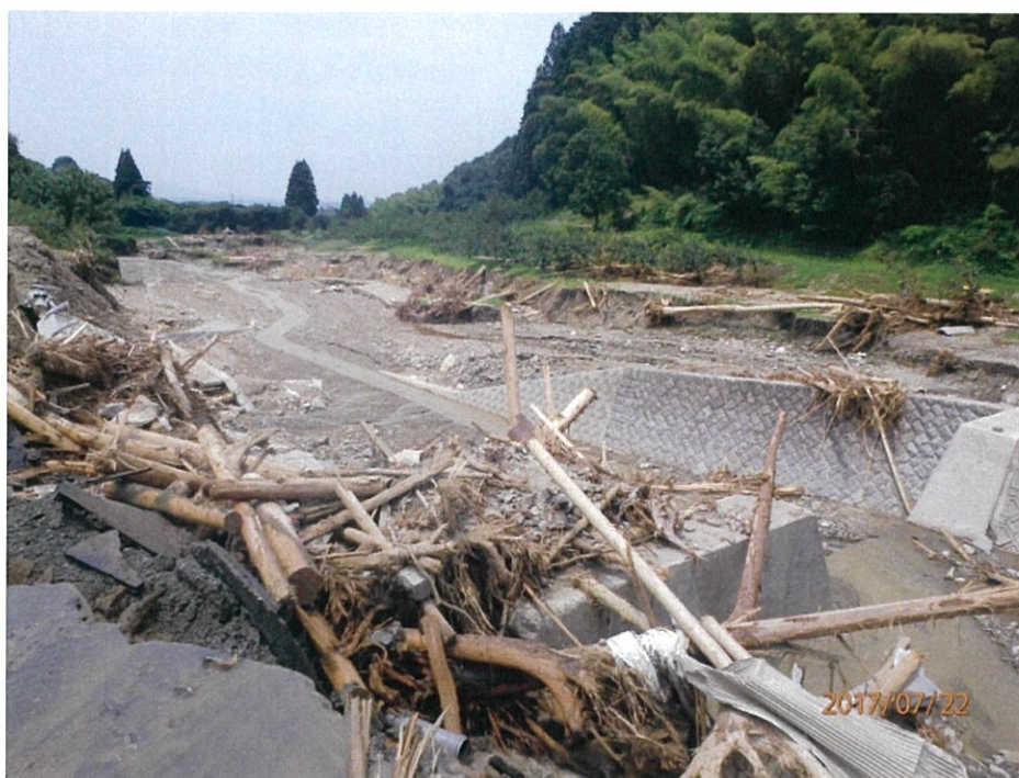
写真-3.4 奈良ヶ谷川・ため池上流区間における河岸洗掘状況（写真奥が下流）
