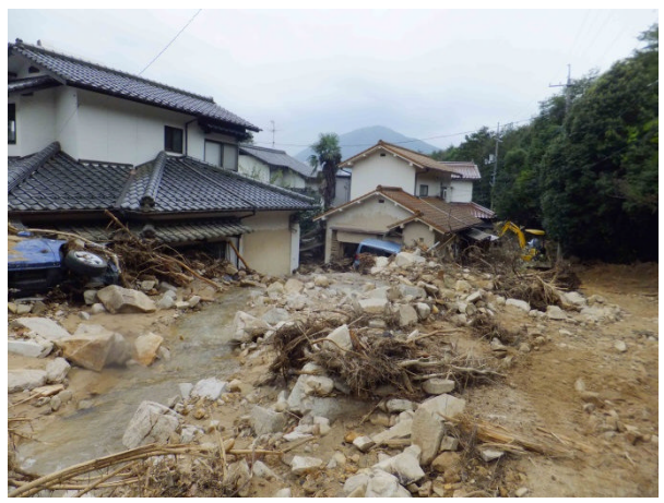
安佐北区可部東6丁目地区の谷すじの家屋の被災状況(この場所は上流の3~4本の小溪流からの土石流が集まって流下した)
