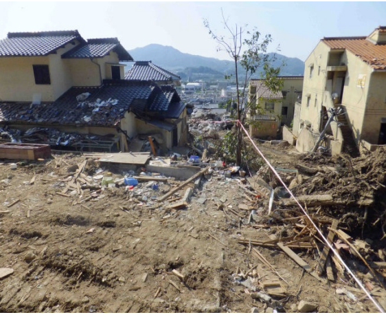
安佐南区八木三丁目県営緑が丘住宅の土石流による被災状況(勾配は8° 程度．花崗岩の巨石と全壊した家屋が確認できる)．
