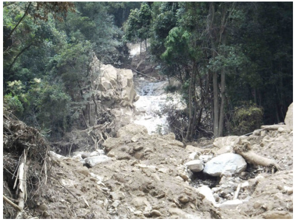
安佐南区八木三丁目県営緑が丘住宅上の土石流流路の状況(住宅地の 上流の谷出口付近．ここまでは勾配が8-10° だが，これより上流は急勾配の露岩した溪床が確認できる．
