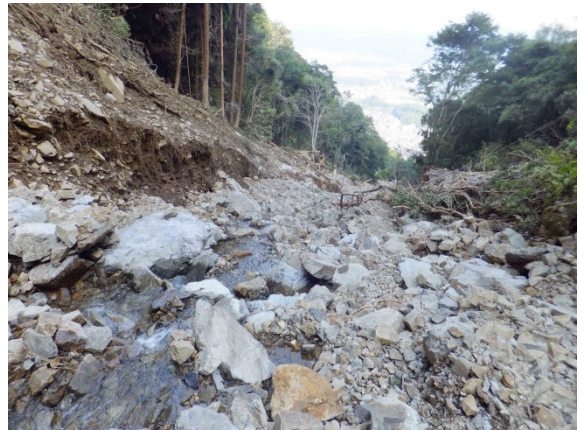
安佐南区八木三丁目阿武の里団地の上の土石流流路の状況(流路勾配24° 前後のところ)．
