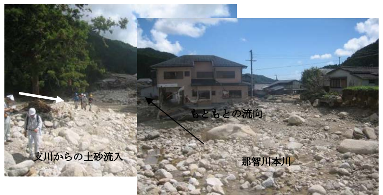
写真-8 支川からの土砂流入による那智川本川の流向変化と土砂災害
