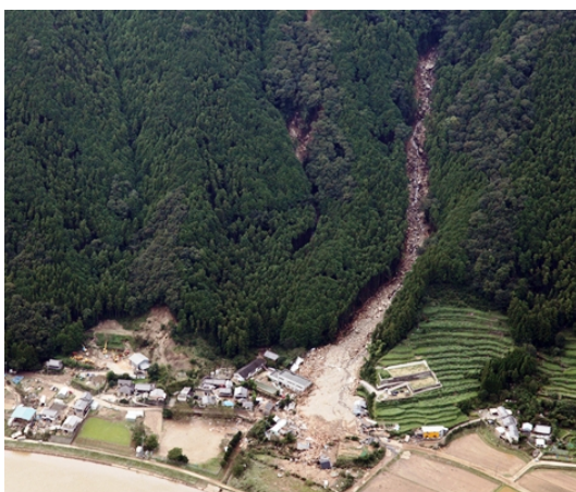
写真-1 土石流の流下・氾濫・堆積区域
