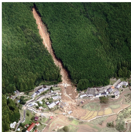
写真-3 崩土の流下・氾濫・堆積区域
