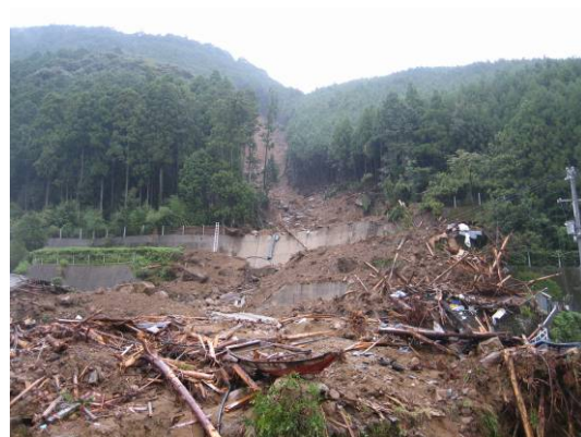
写真-4 待受け擁壁を越流した崩土の氾濫・堆積場の状況
