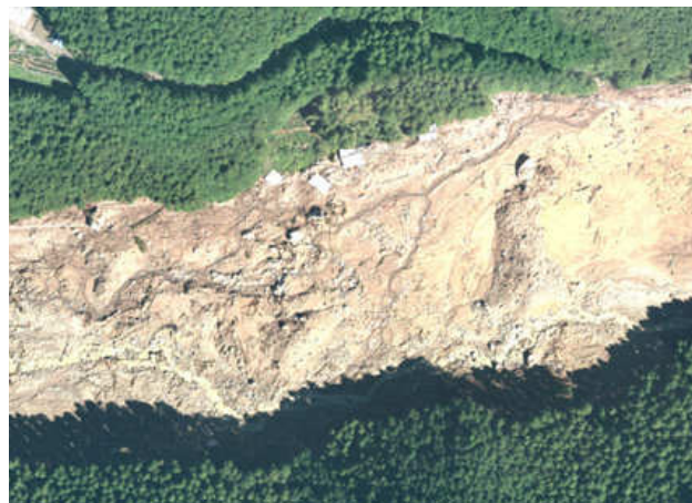
河道状況（詳細調査後）
