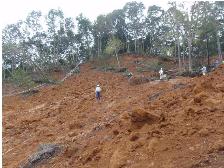
写真-3.5.2 中腹より滑落崖を望む（2011年9月11日）
