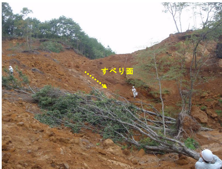
写真-3.5.3 左側方崖に露出したすべり面（2011年9月11日）
