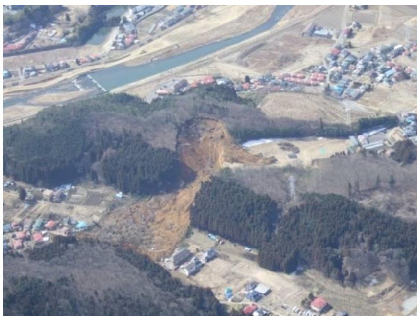
写真-3.5.1 ヘリから撮影した全景（2011年3月）
