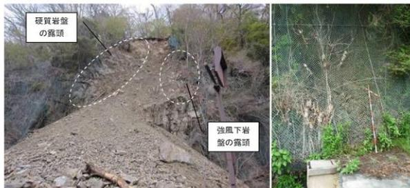
写真-3.3.6 断層崩壊の状況(左)と断層崩壊による落石(右)
