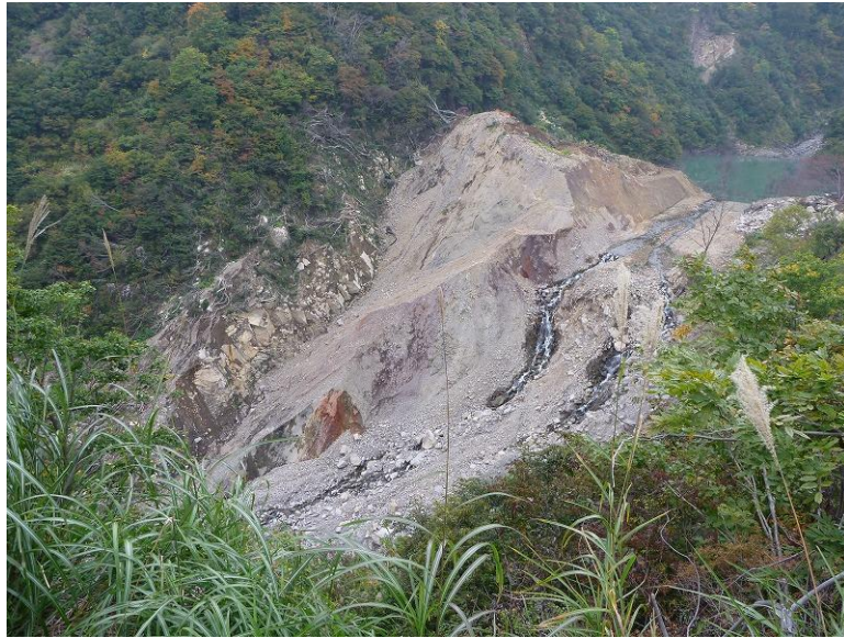
写真-2.5.3 東入沢川 下流側崩壊地の湛水部と開削状況 (2011年10月15日撮影)
