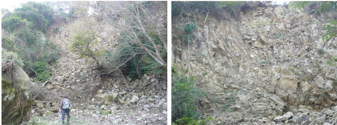
写真-2-1 大塚層・シルト岩部層の露頭 (右写真は左写真の斜面上部の拡大)
