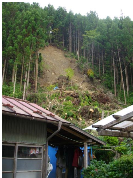
写真-2.1.1 一関市東山町で本震（3月11日）により発生した斜面崩壊、今後も拡大崩壊の危険性が高く人家への影響が懸念される（一関市東山町松川三室平 2011年9月26日撮影）
